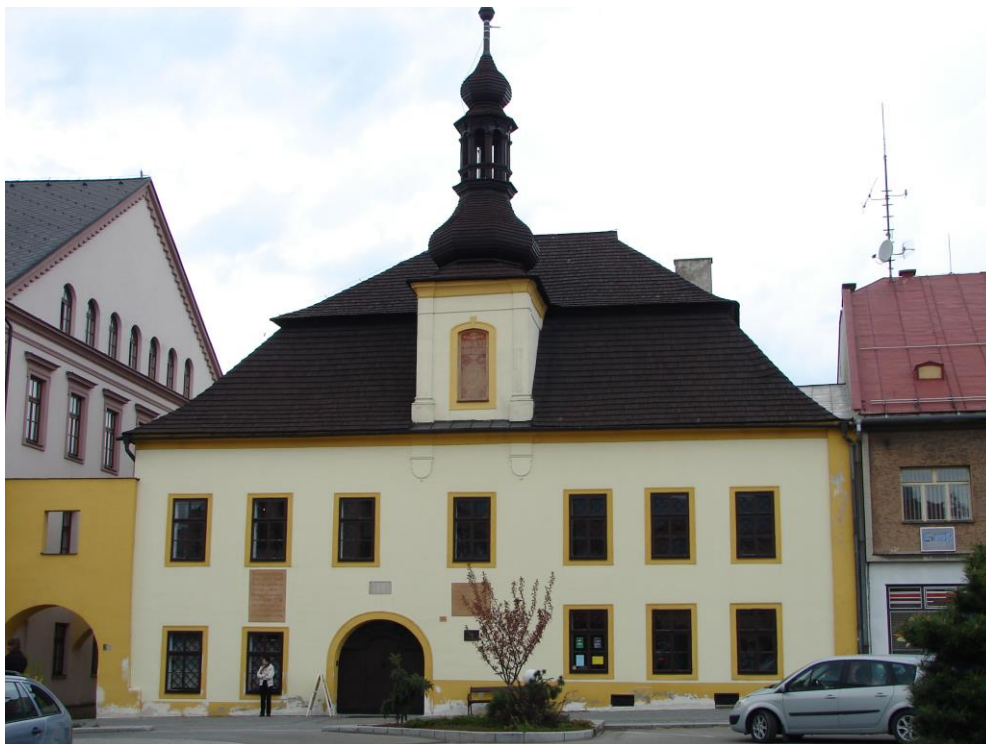
Stav před obnovou
