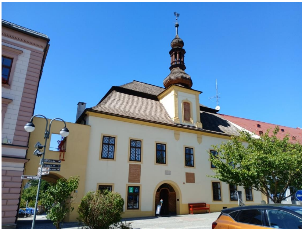
Stav po obnově
