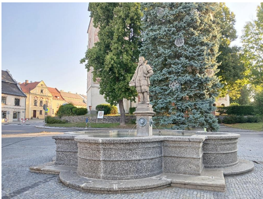
Stav po obnově
